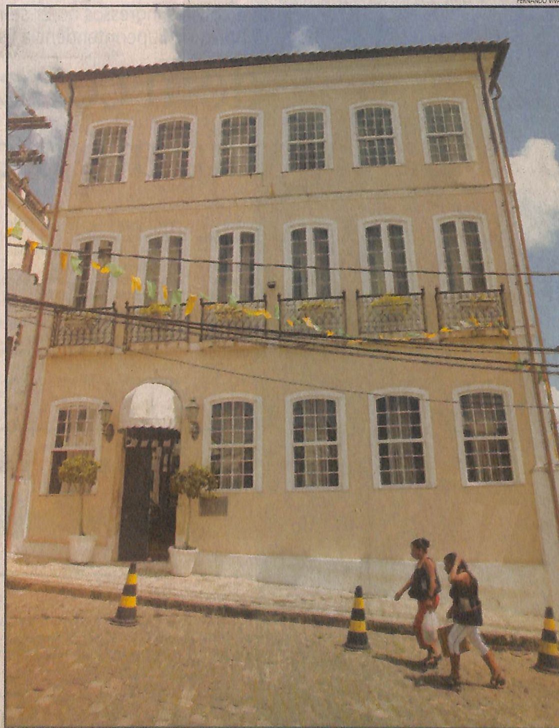
Das ruínas do velho sobrado, construído no início do século XIX, surgiu o Hotel das Portas Velhas
