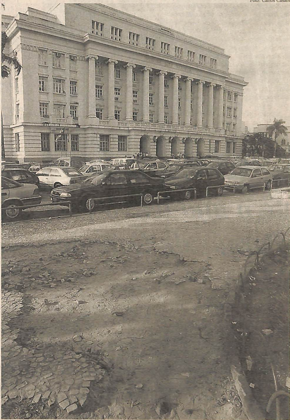
Passeios esburacados, grama destruída; sinais de degradação da praça
