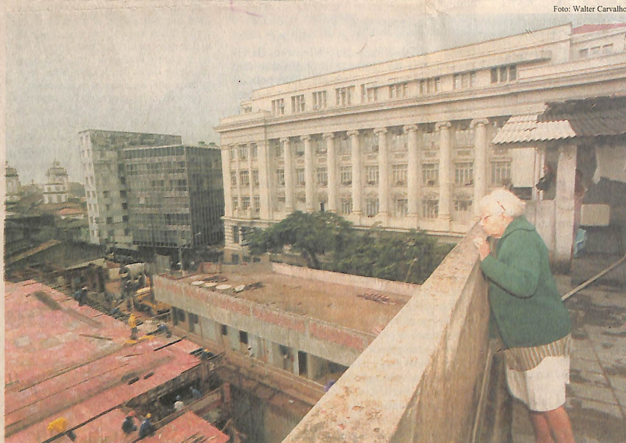
Dona Lourdes acompanha, do terraço de sua residência, as obras do seu novo e incômodo vizinho
