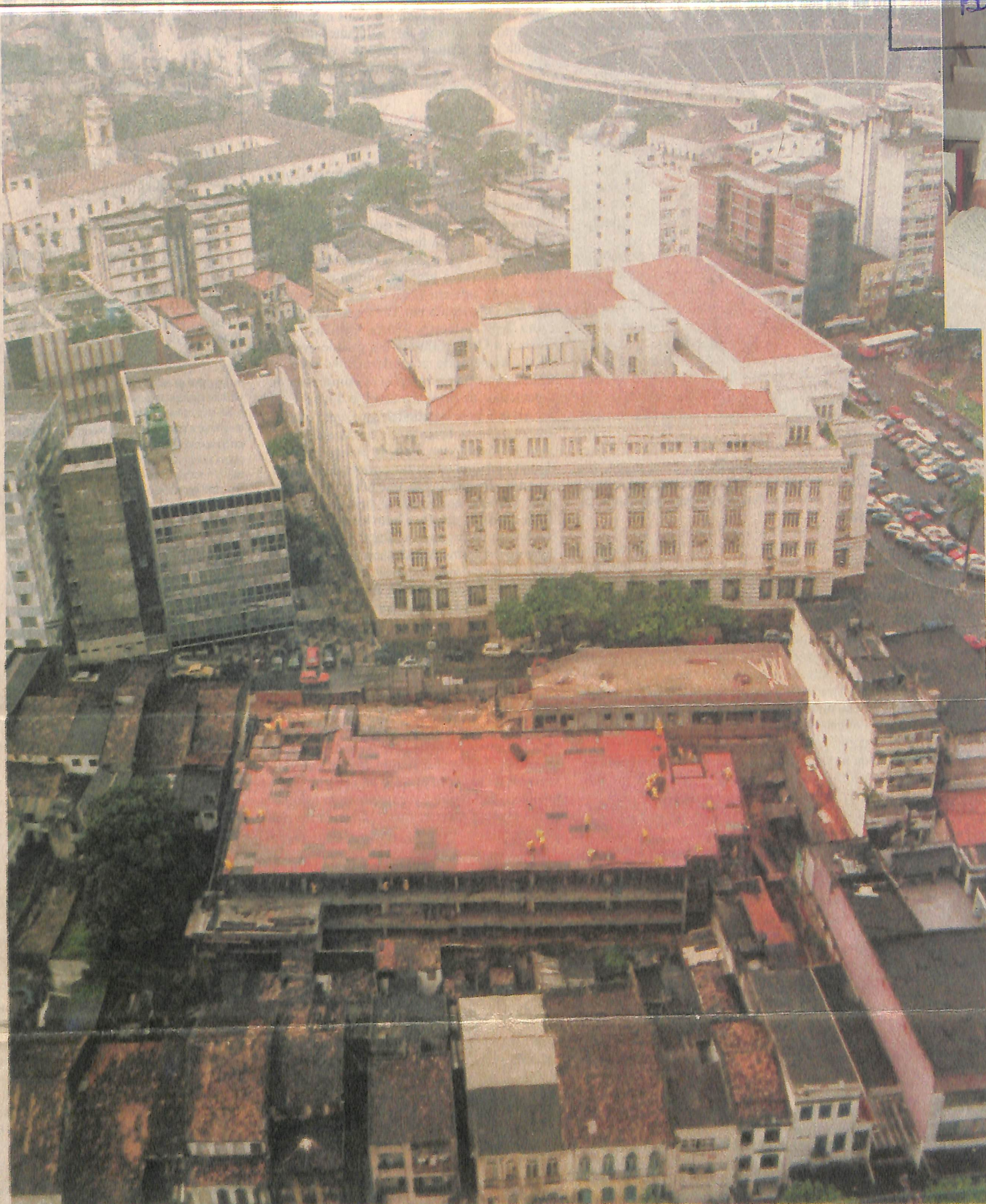
A construção do anexo do fórum tem sido contestada desde o seu início, mas a obra prossegue, apesar dos prejuízos que causa aos moradores
