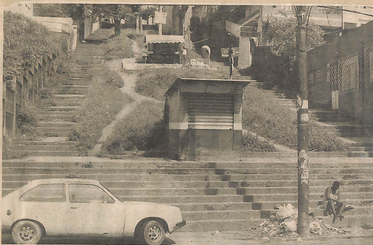
O mato cresce livremente e o lixo se acumula junto à escadaria, que é uma via de acesso importante a Nazaré
