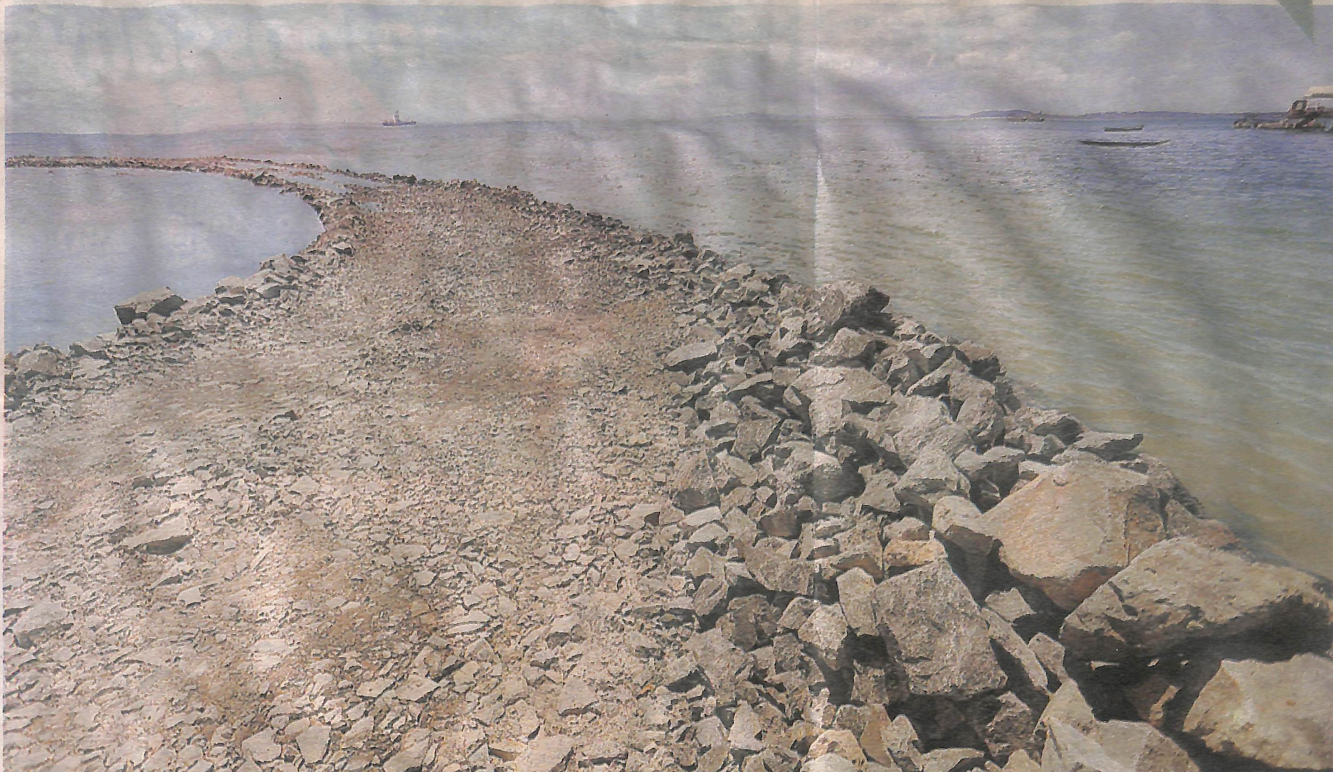
Pista de borda, que ligará a área detrás da Igreja do Bonfim à Pedra Furada, no Monte Serrat, começou a ser construída há menos de um mês. Projeto da Conder preocupa moradores
