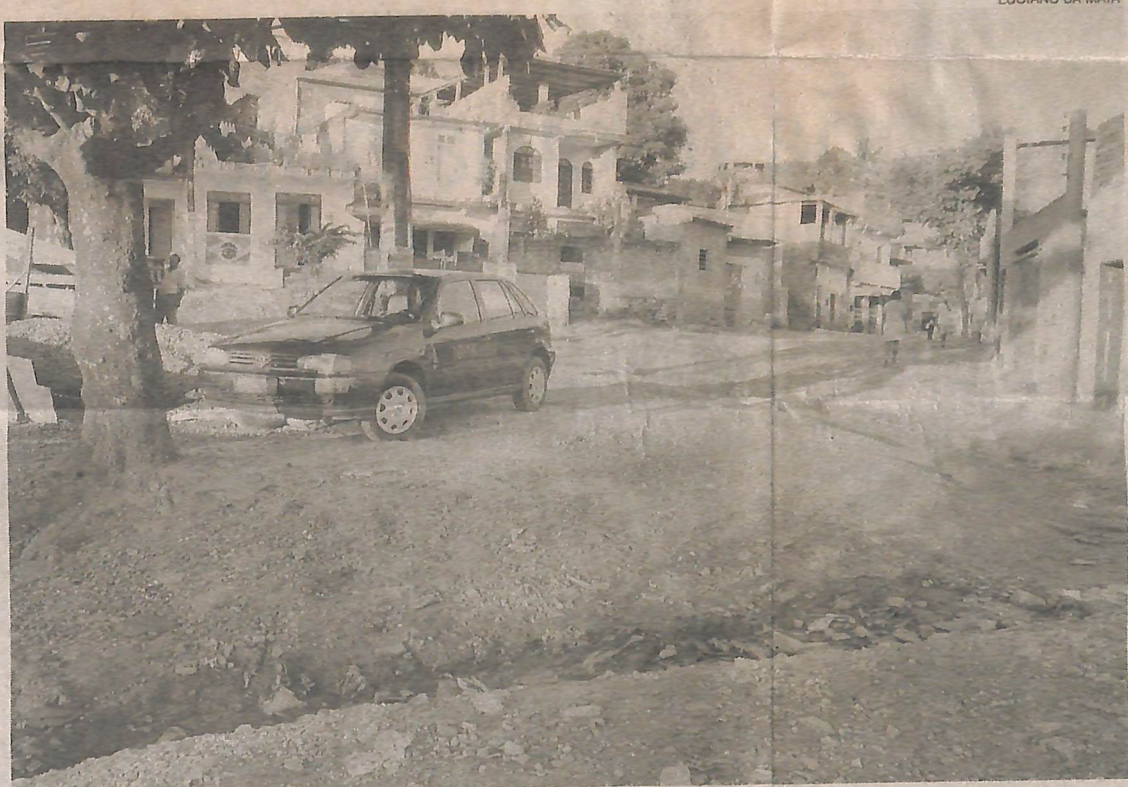
Falta pavimentação na Rua Coronel Fabriciano e carros têm dificuldade de trafegar
