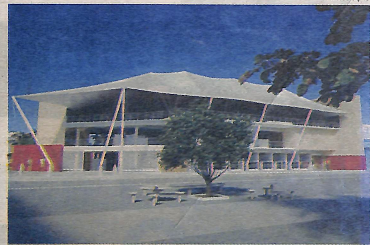
Novo mercado terá três andares, mas início das obras não tem data
