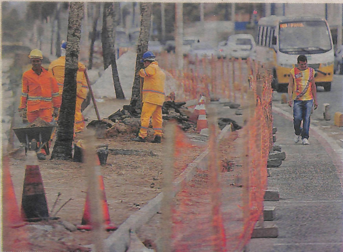
Obras de revitalização da orla de Itapuã já começaram. Prefeitura diz que estará pronto até fim do ano
