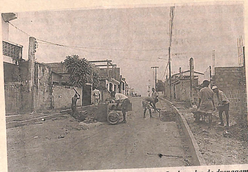
Os trabalhos incluem pavimentação e colocação de redes de drenagem
