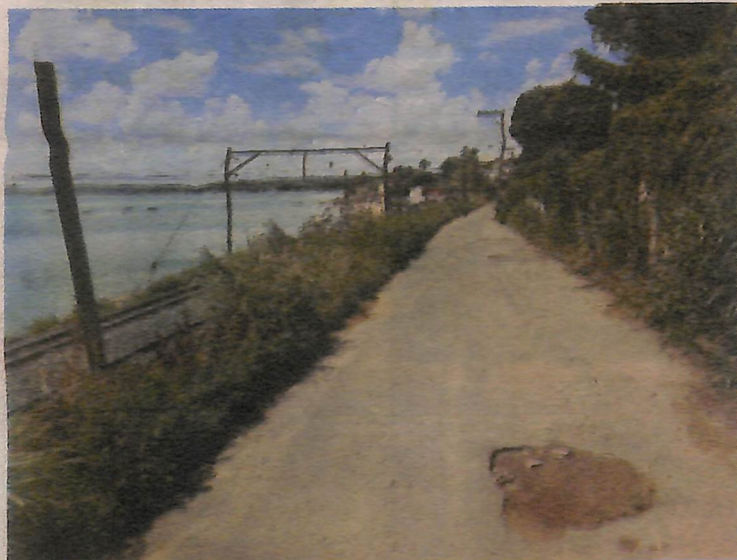
Reforma compreende trecho da Almeida Brandão em Plataforma
