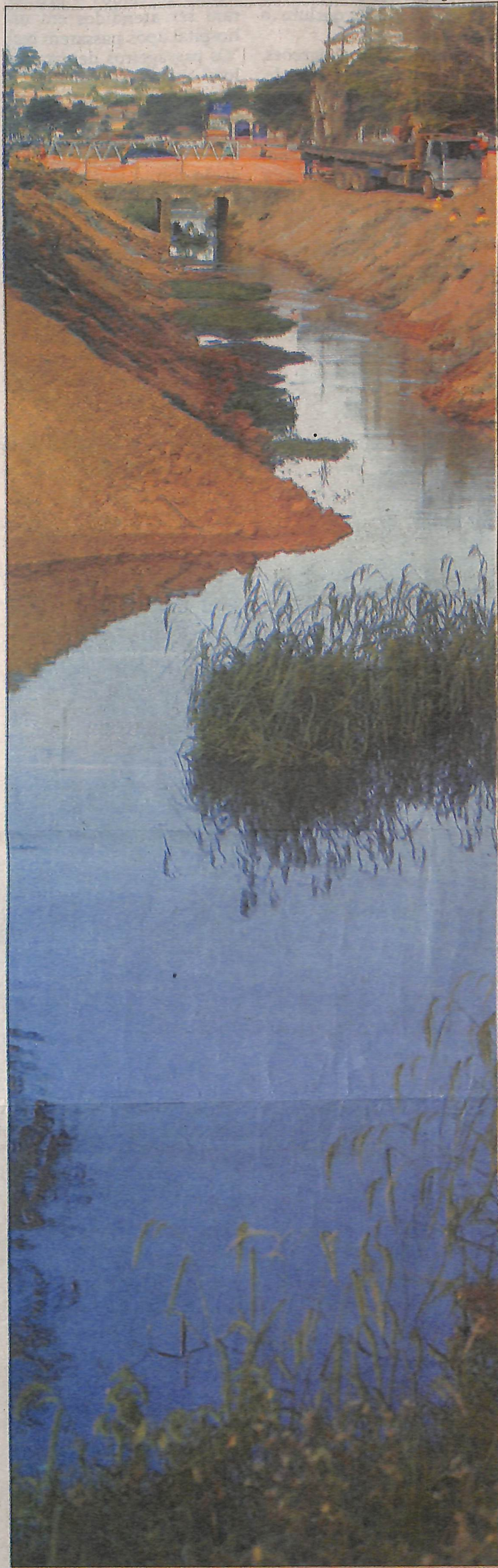
Leito do Rio das Pedras, no Imbuí: obra será retomada
