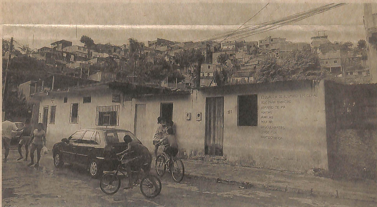
O processo desordenado de ocupação de encostas da rodovia BR-324 originou da maioria dos problemas
