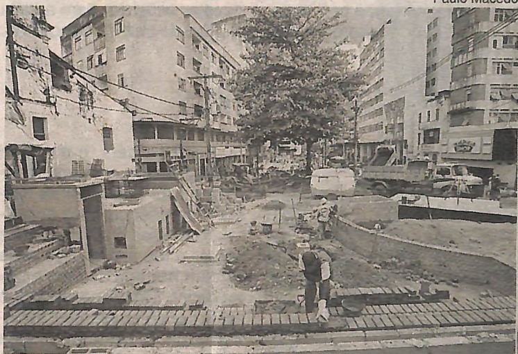
As obras prosseguem em ritmo intenso no largo
