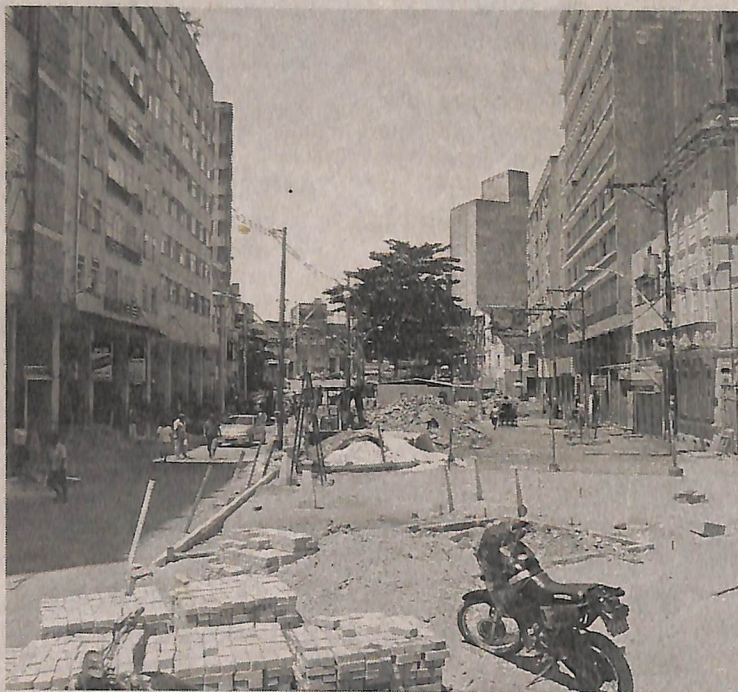
Os serviços estão dificultando a circulação no largo
