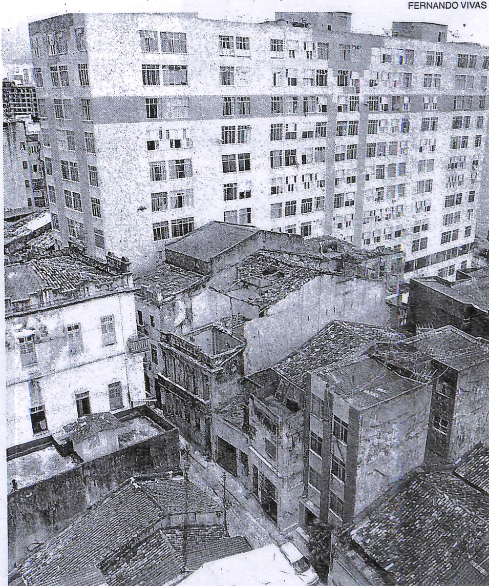
Ruína é depósito de lixo no Areal de Cima, Centro de Salvador
