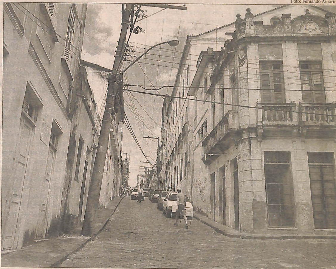
A área do Largo Dois de Julho, que já foi habitada pela classe média, hoje está degradada
