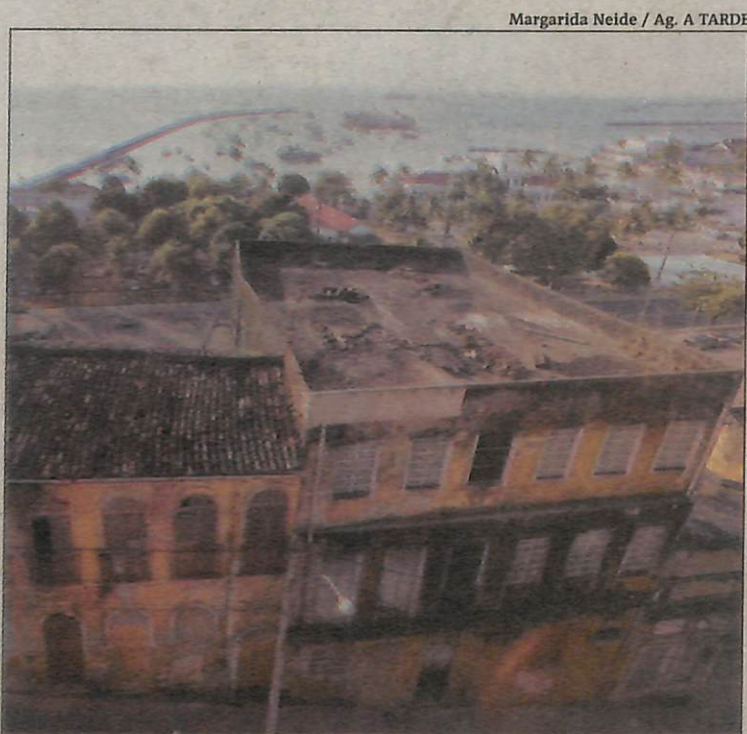
Casarões na Ladeira da Preguiça precisam de reforma
