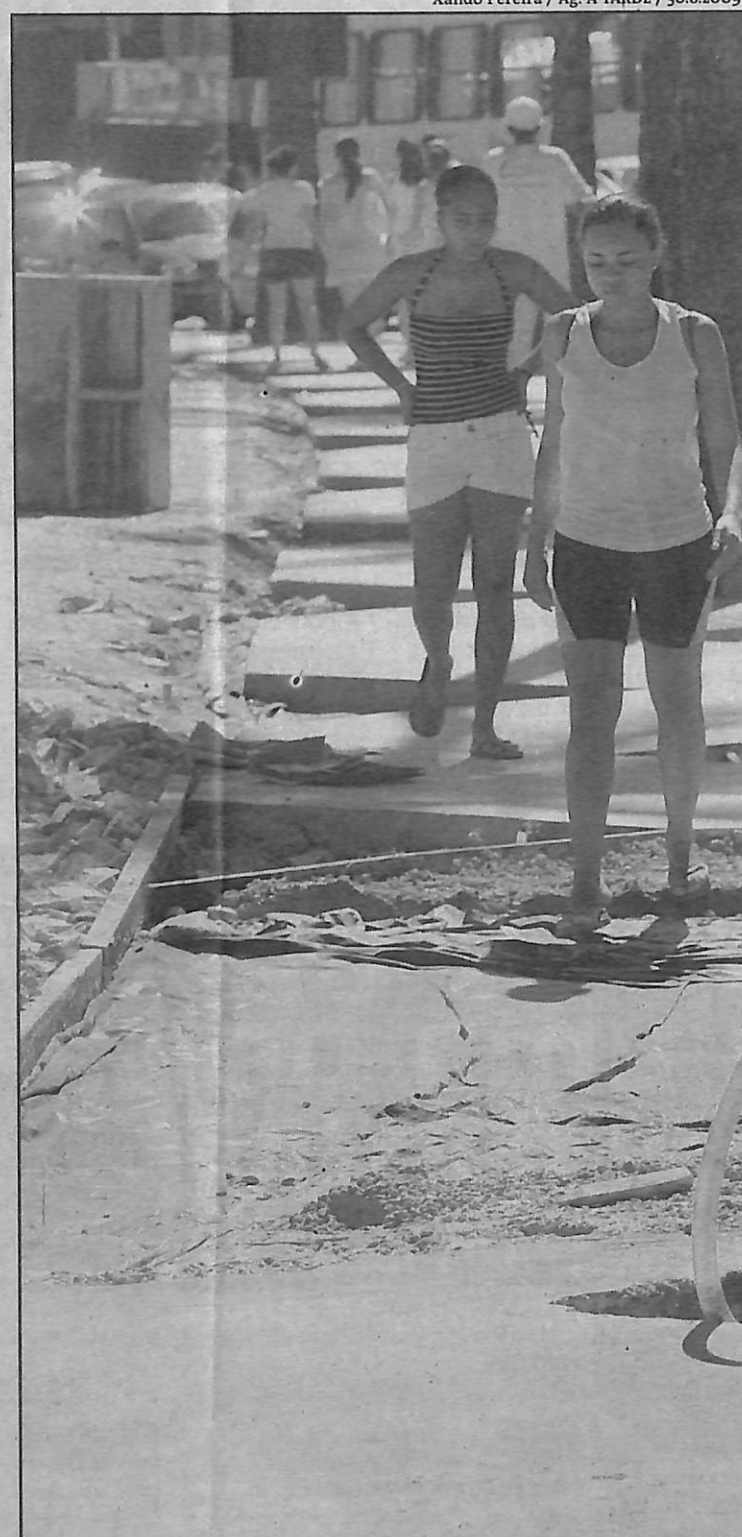
Transeuntes em trecho da obra feita em 2008 na Barra
