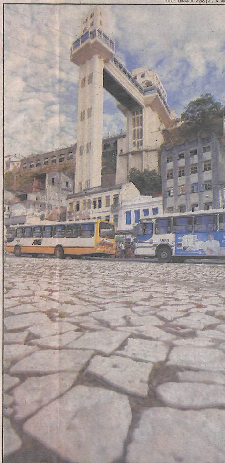
Substituição das pedras por granito e concreto custará R$ R$ 9,8 mi
