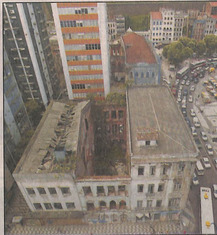
O novo Hilton Hotel será instalado nesta área da Praça Cayru
