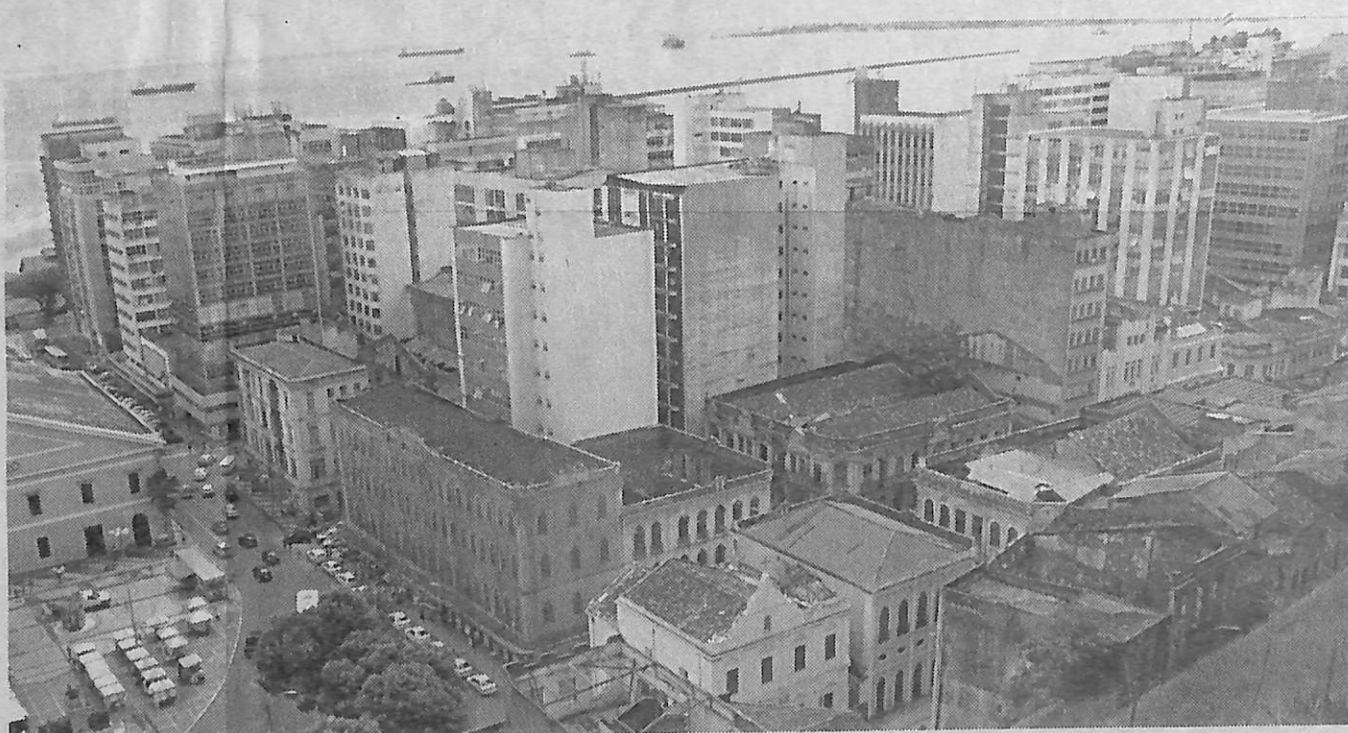
Prédios antigos estão recebendo escritórios de empresas de diversos ramos da economia
