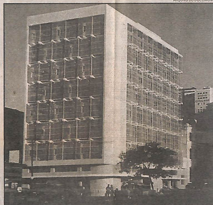
O Caramuru, ainda com os "brises-soleil", grandes painéis metálicos
