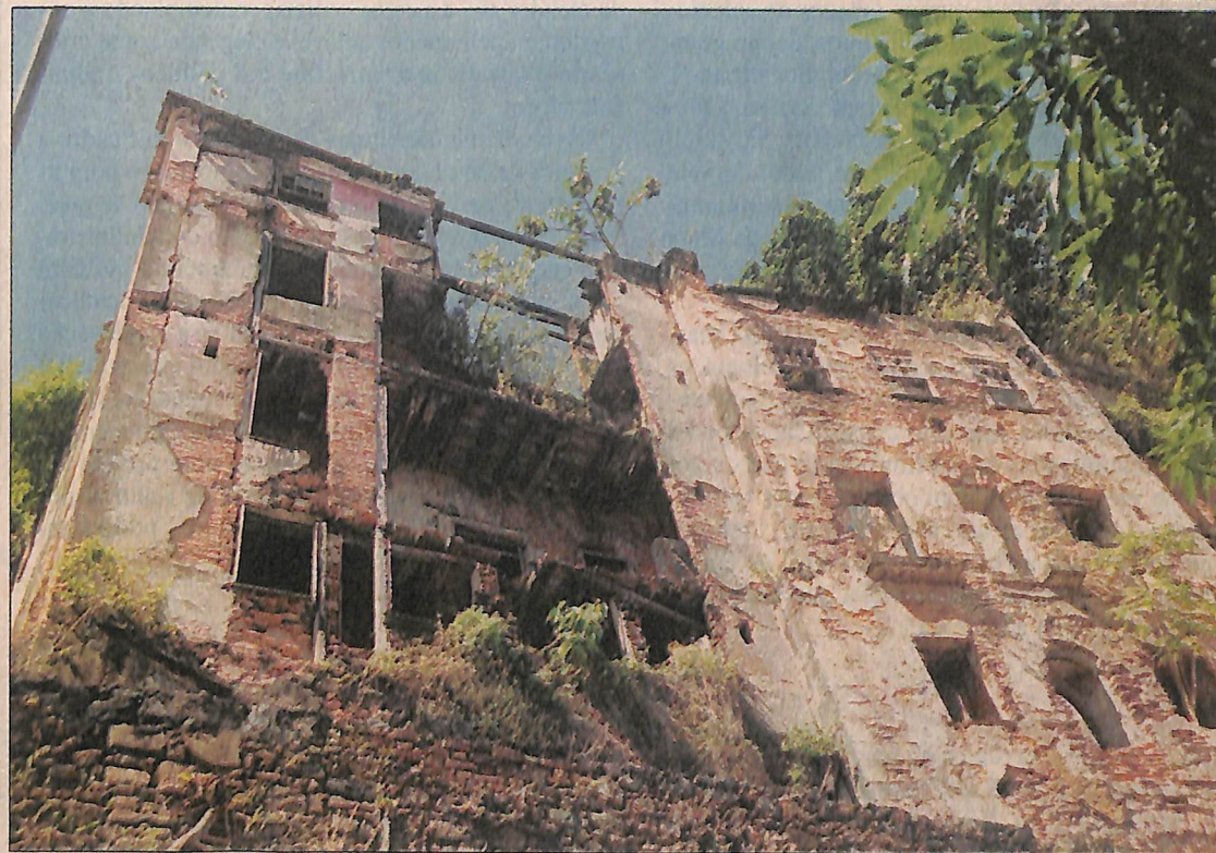
Nos escombros dos casarões abandonados da Misericórdia sobrevive uma população de excluídos
