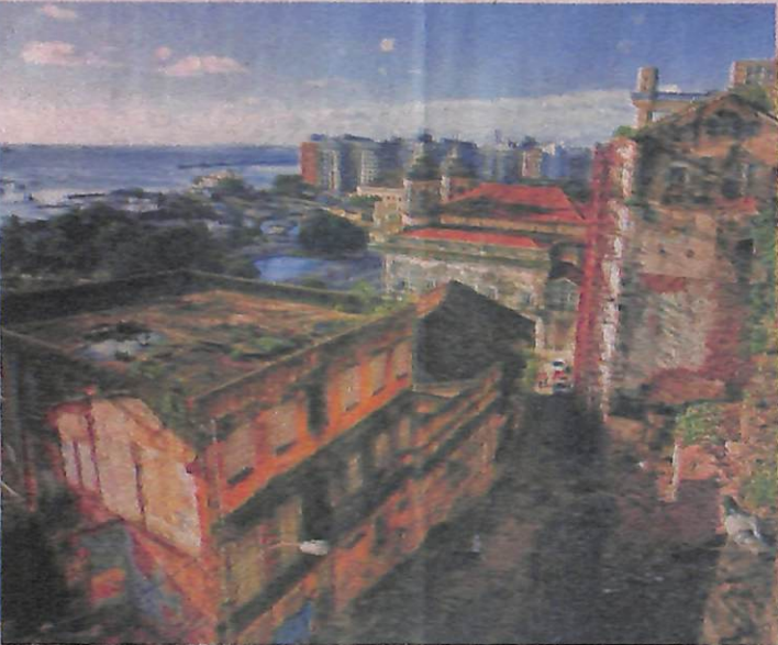
Casarão na ladeira da Montanha carece de reforma
