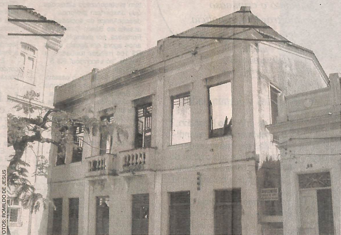
Antigos casarões, hoje autênticas ruínas onde só as paredes estão de pé, podem desabar
