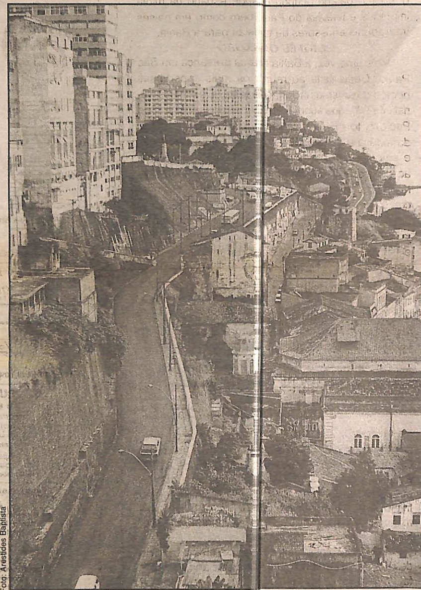
Casas em ruínas na Ladeira da Montanha serão recuperadas
