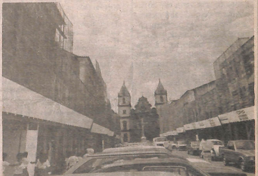
As obras da 4ª etapa começaram em novembro passado
