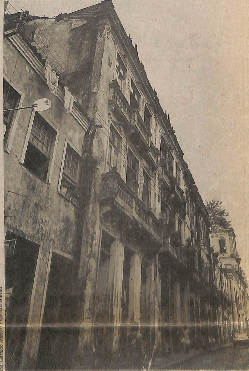
Em 1969, abandonado total. Em 1993, os mesmos prédios...
