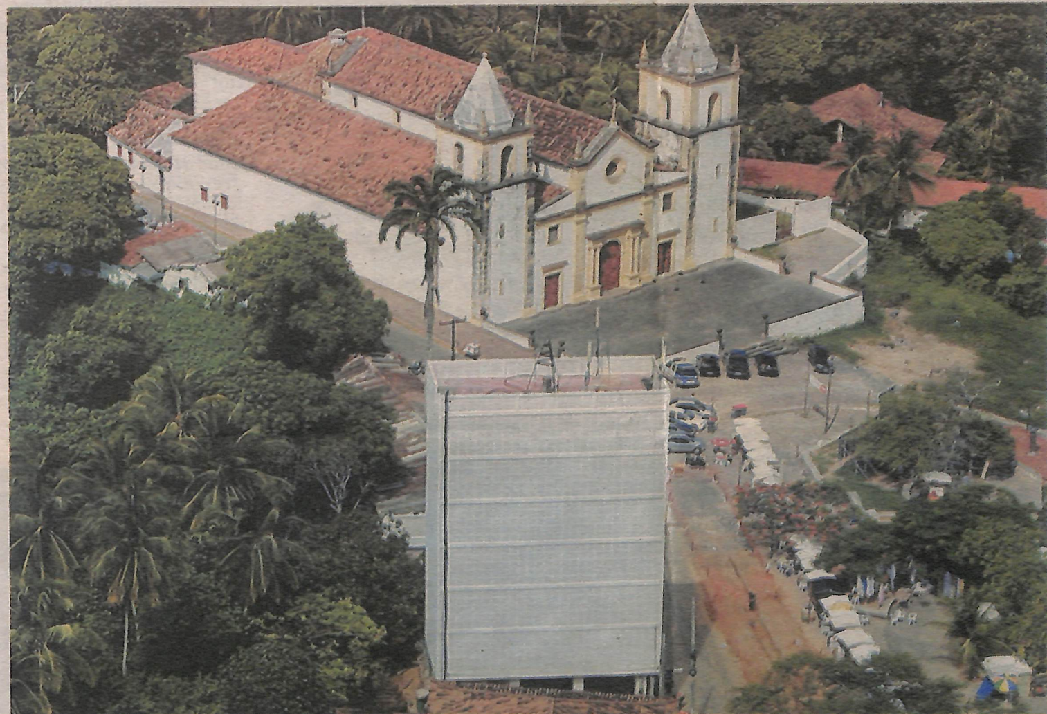
No centro antigo de Olinda, está sendo construído um elevador panorâmico no prédio da caixa d'água, que será transformado em mirante
