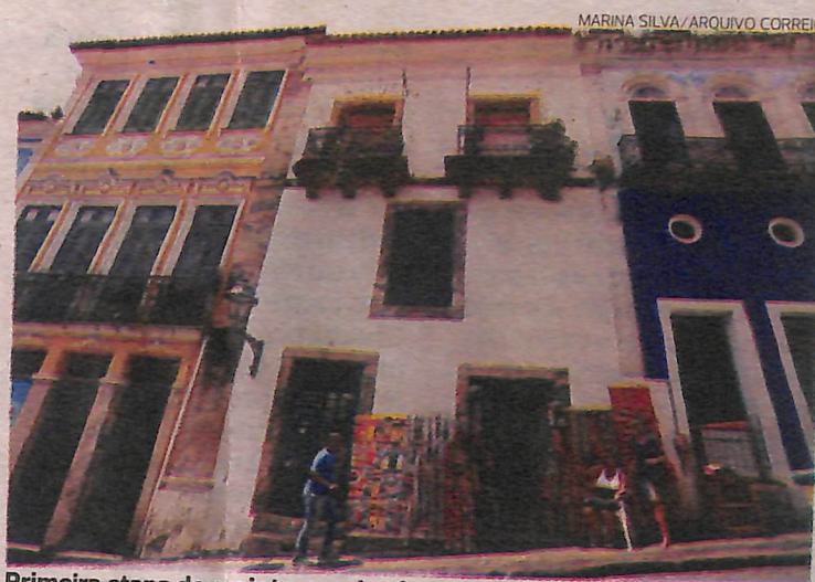
Primeira etapa do projeto prevê reformas estruturais no casarão 47
