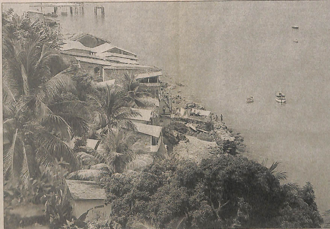
Ocupação da encosta, acima e abaixo da Avenida do Contorno, resultou em duas comunidades
