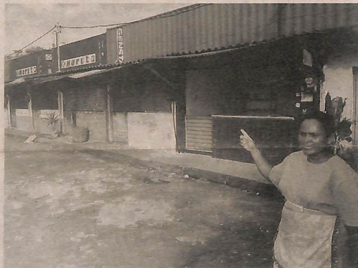
Comerciantes não têm esperança na reforma do centro comercial
