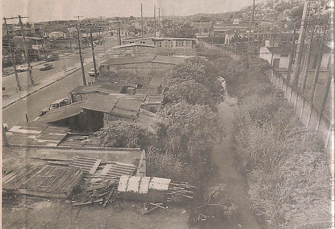
O saneamento é uma das principais necessidades e a rede de escoamento não evita os alagamentos
