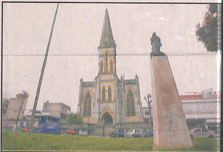
IGREJA DOS MARES | Localizado no Largo dos Mares, este templo católico foi construído no século 20 e chama atenção pelos enormes vitrais e pelo estilo neogótico, que difere dos de outras igrejas da Cidade Baixa. Foto Elói Corrêa
