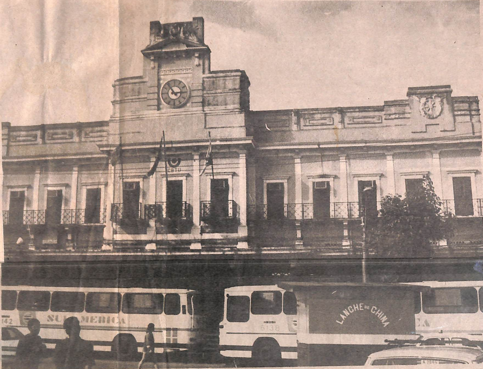
O prédio da Estação Ferroviária da Calçada foi construído em 1860 e levou quatro anos para ficar pronto
