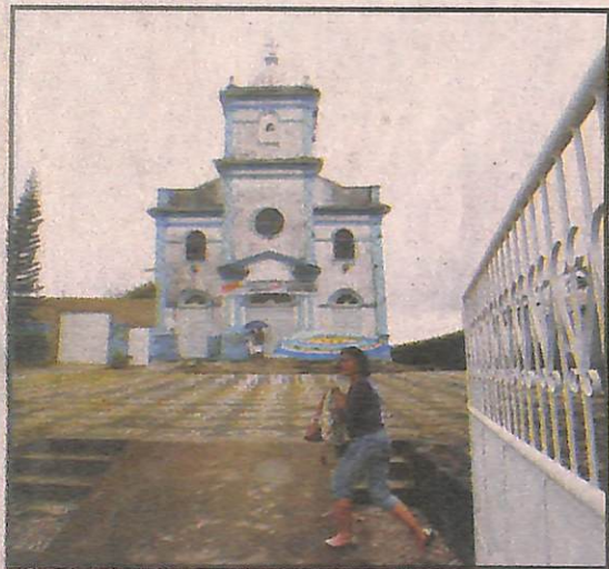
Templo no Largo dos Paranhos está em reforma
