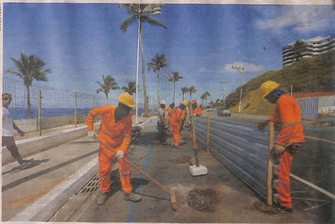
Homens trabalhando entre a Barra e a Ondina, próximo ao Clube Espanhol: tráfego não ficará interditado
