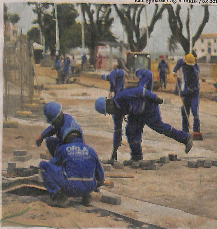
Operários seguem trabalhando no novo calçadão da orla
