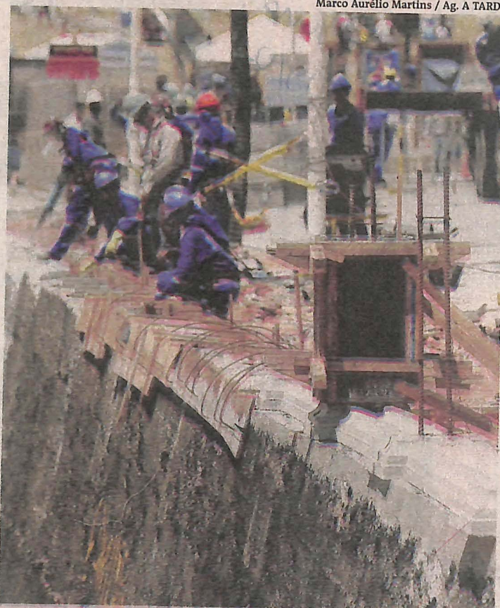
Operários trabalham para reconstruir a balaustrada
