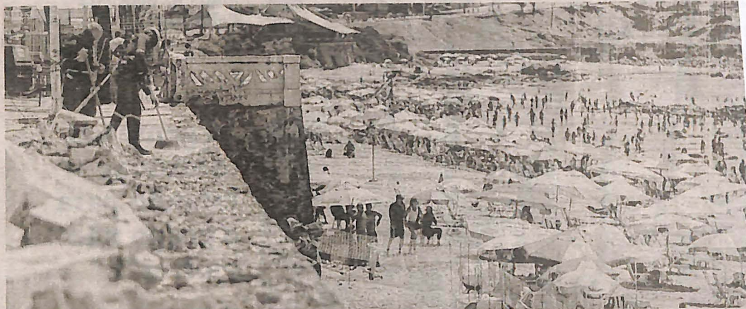
Agentes da prefeitura começaram ontem a remover os escombros da estrutura
