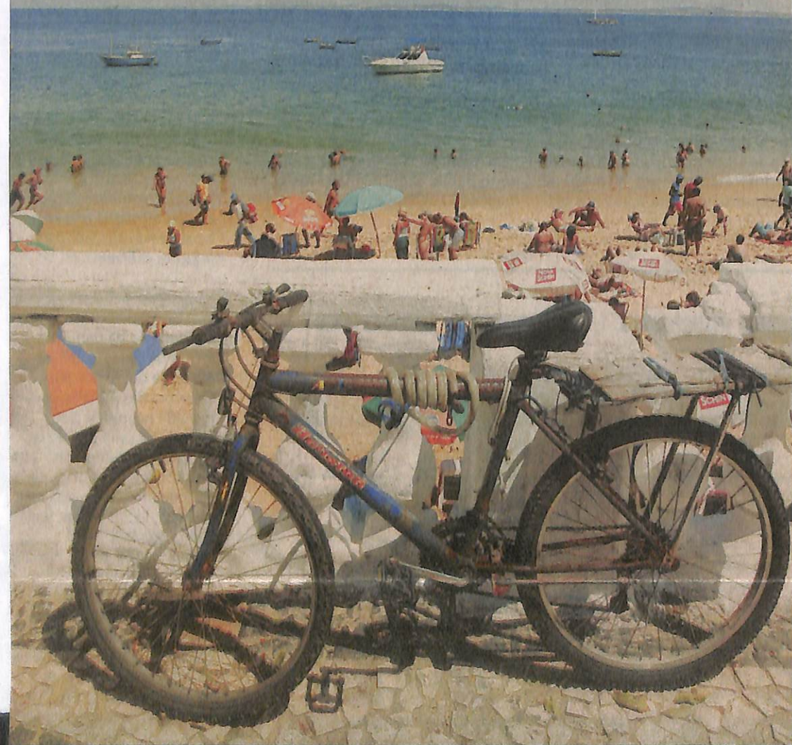
Balastrada está quebrada e serve para prender a bicicleta, por falta de estacionamento adequado
