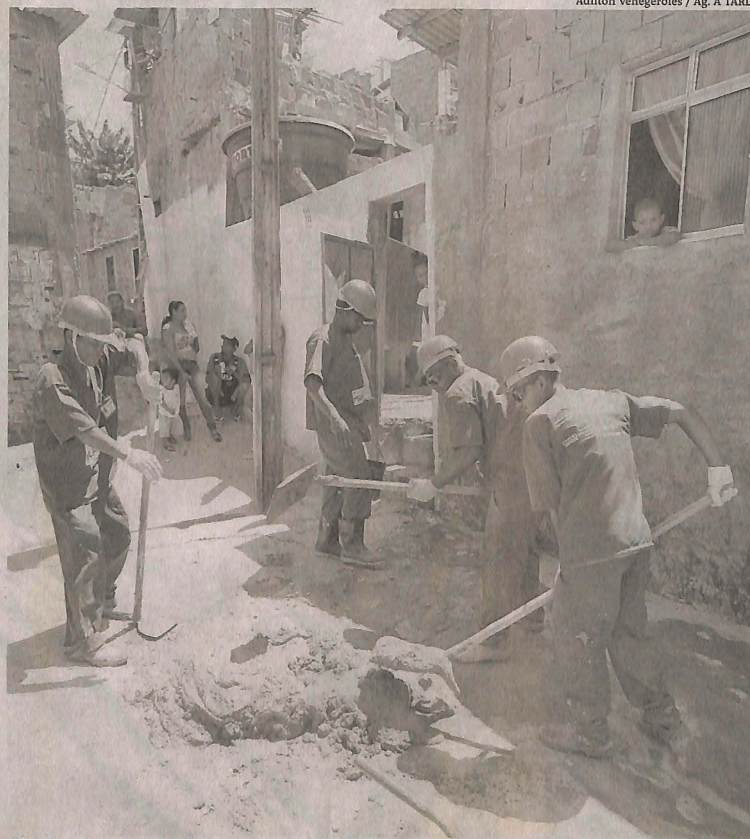
Observados por moradores, operários preparam material a ser usado nos reparos
