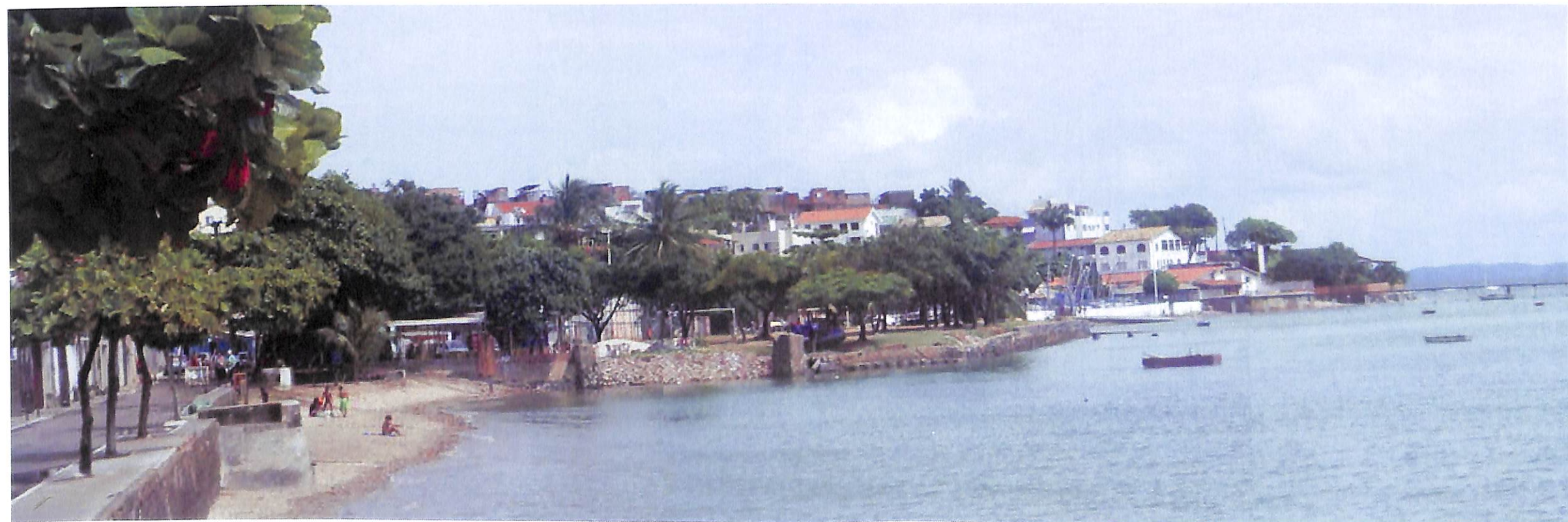
23 - Vista panorâmica da Praça Porto da Lenha, antes das obras de requalificação.
