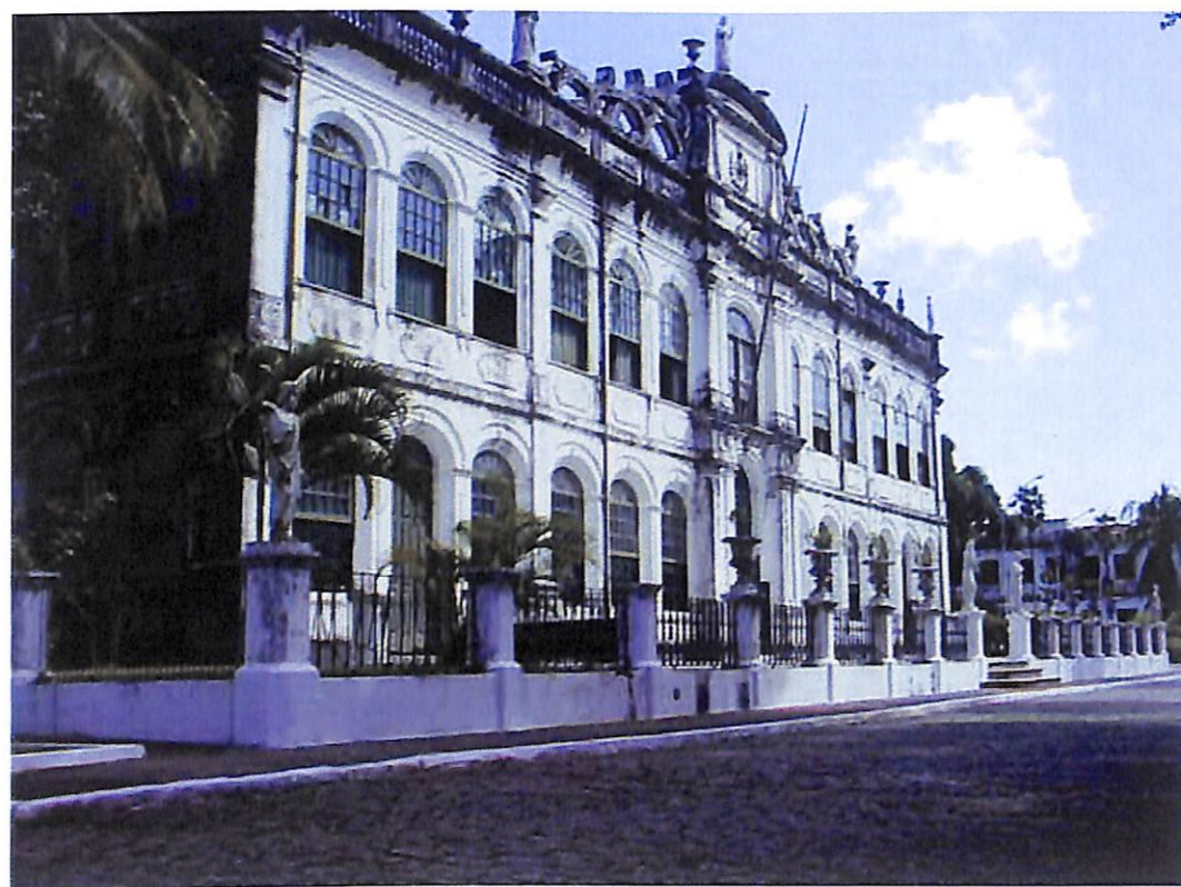
48 - Abrigo Dom Pedro II (tombado pelo IPHAN) - Av. Luiz Tarquínio.
