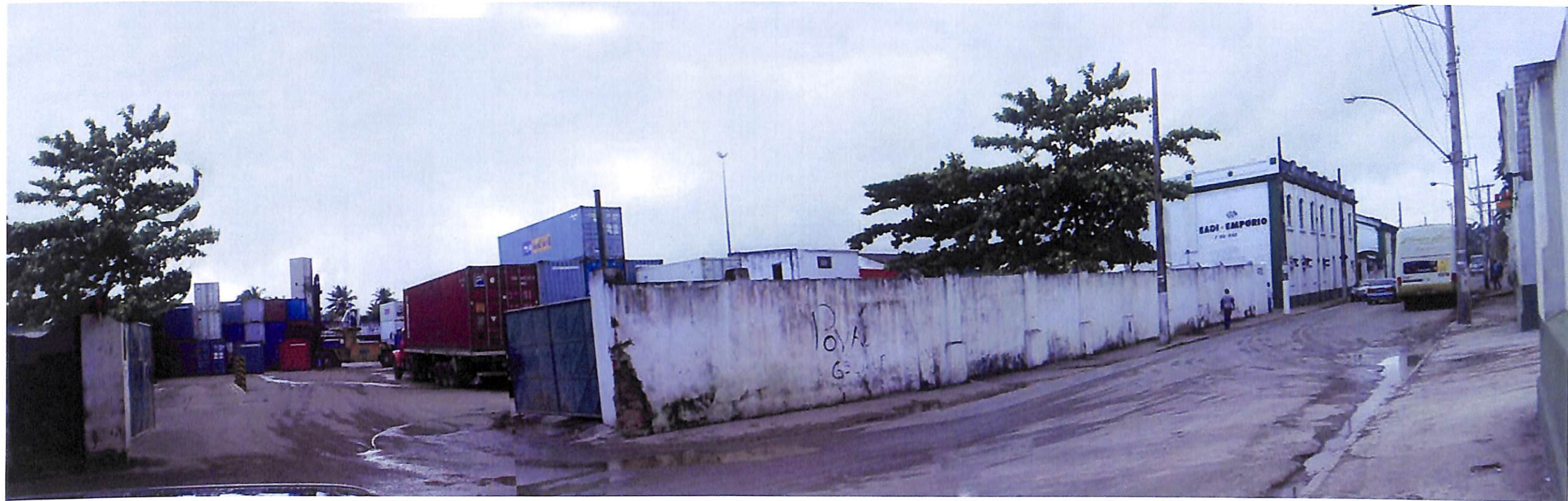
43 - Depósito da EADI Empório - Av. Luiz Tarquínio.
