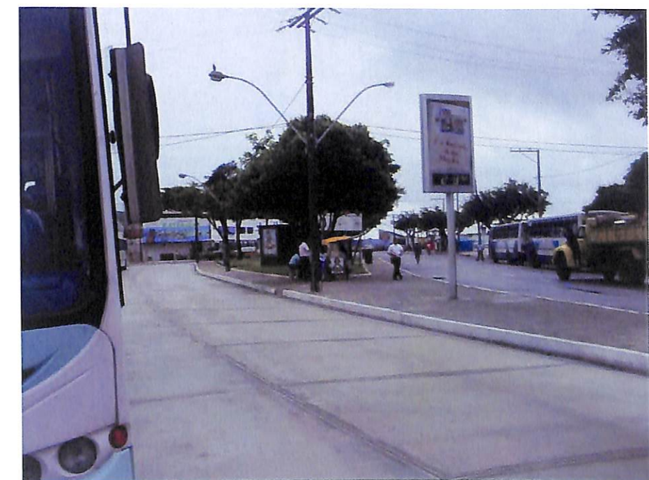
08 - Terminal da Ribeira após a conclusão das obras - Largo da Ribeira.
