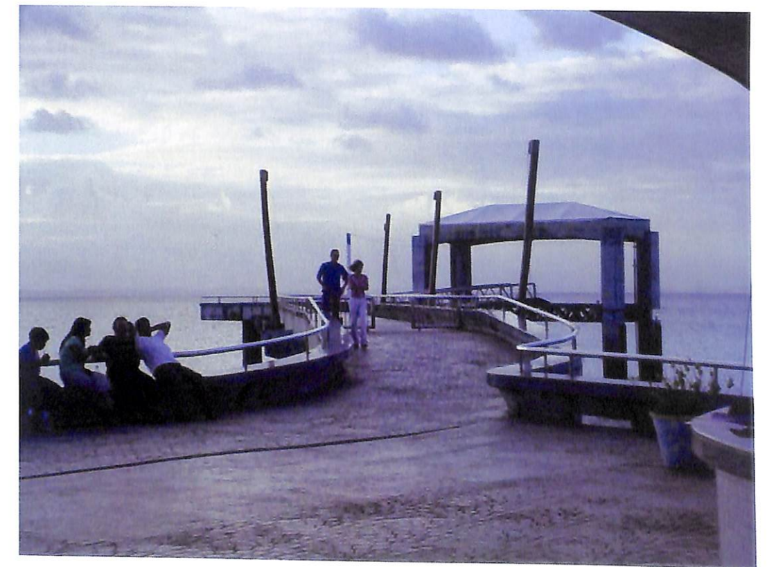
35 - Terminal Marítimo da Ponta de Humaitá
