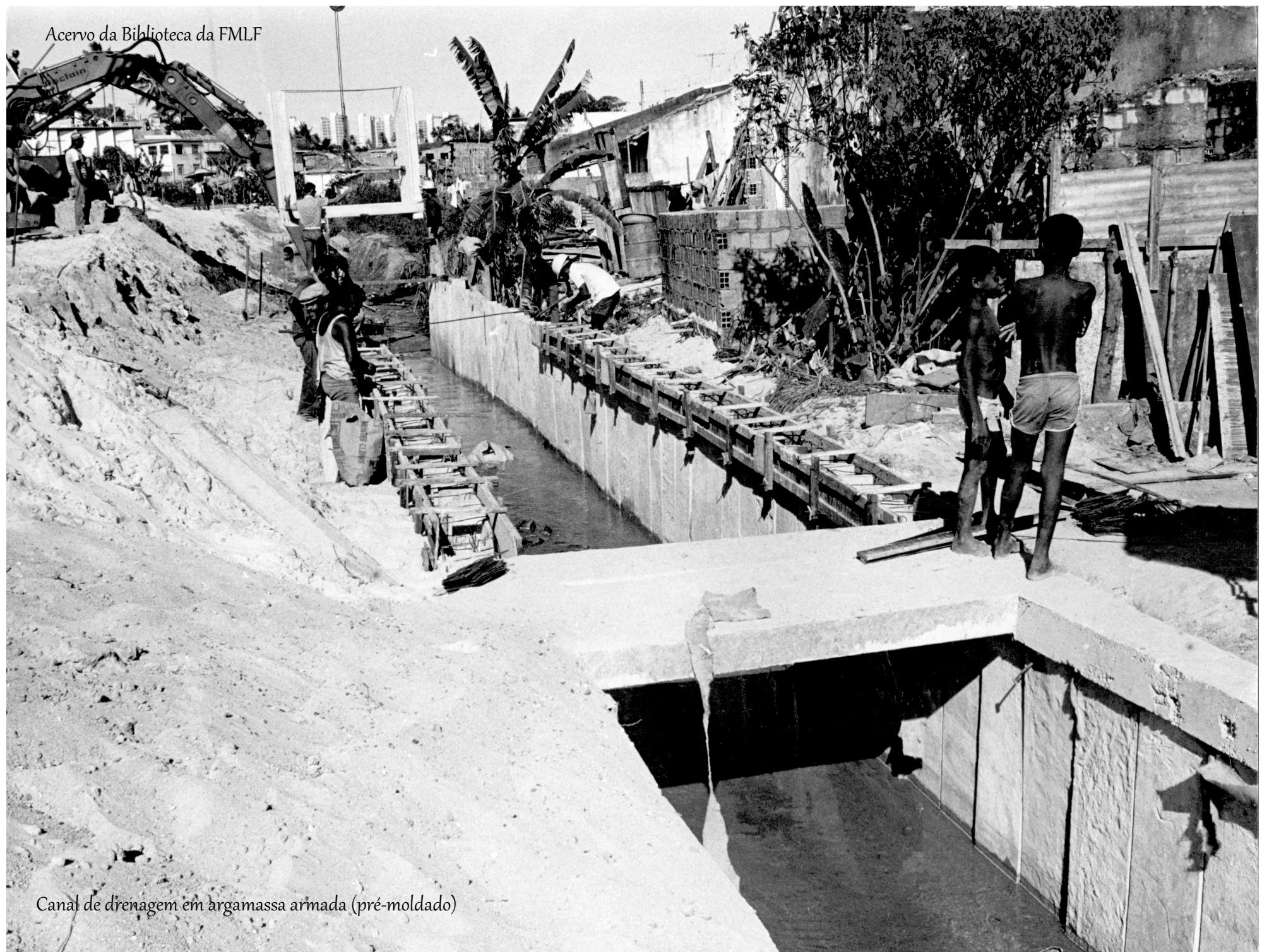
Canal de drenagem em argamassa armada (pré-moldado)
