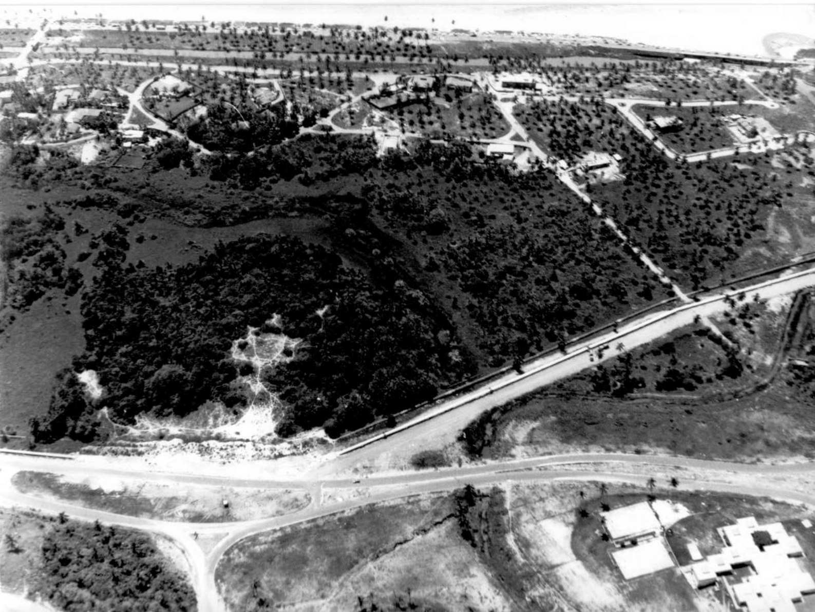
Estrada da Embasa - Patamares
