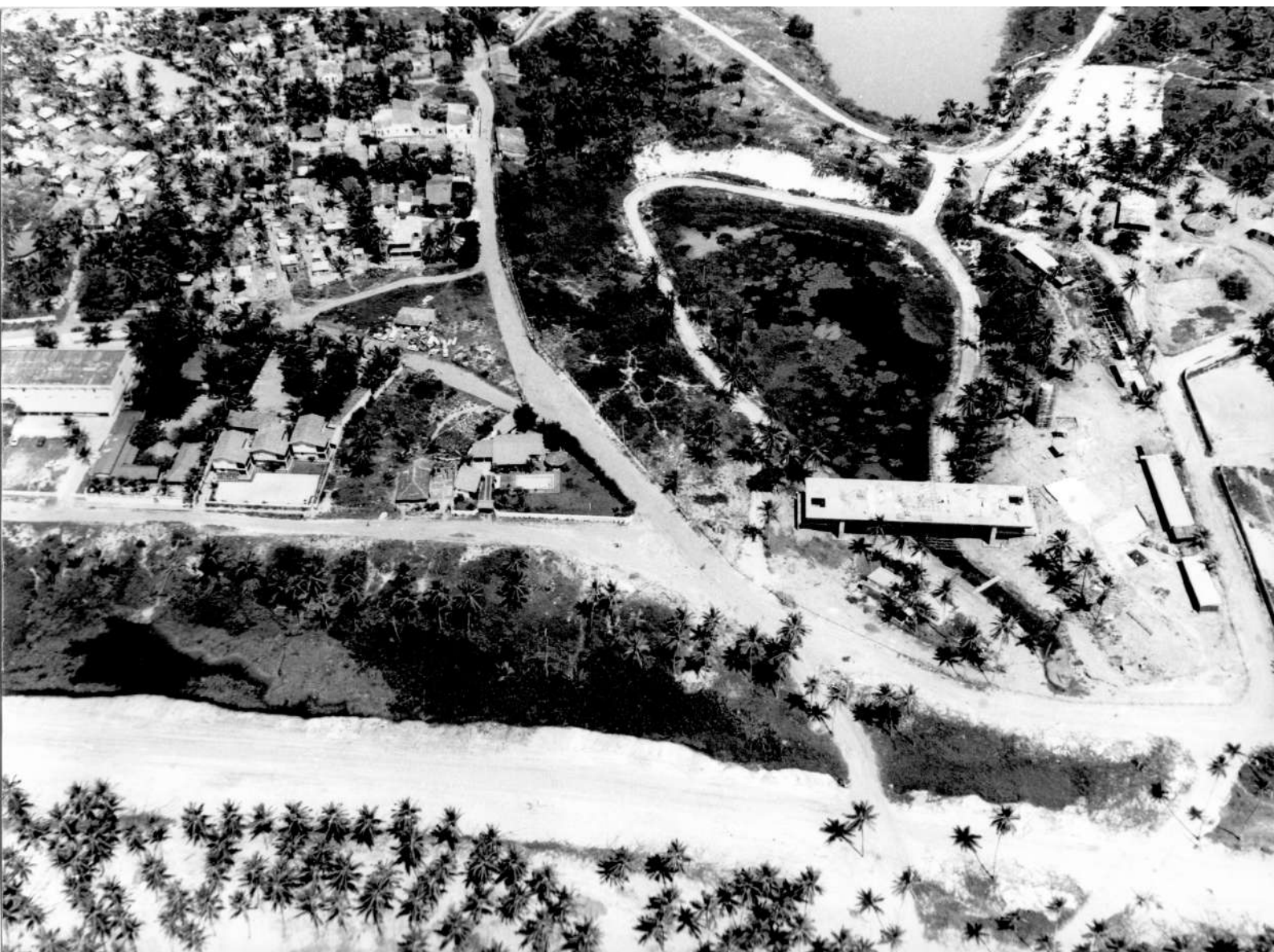
Estrada da Embasa - Pituaçu
