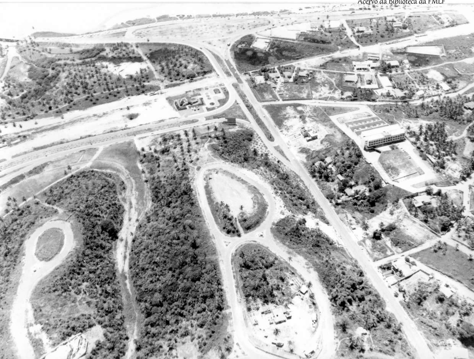
Av. Pinto de Aguiar - Patamares
