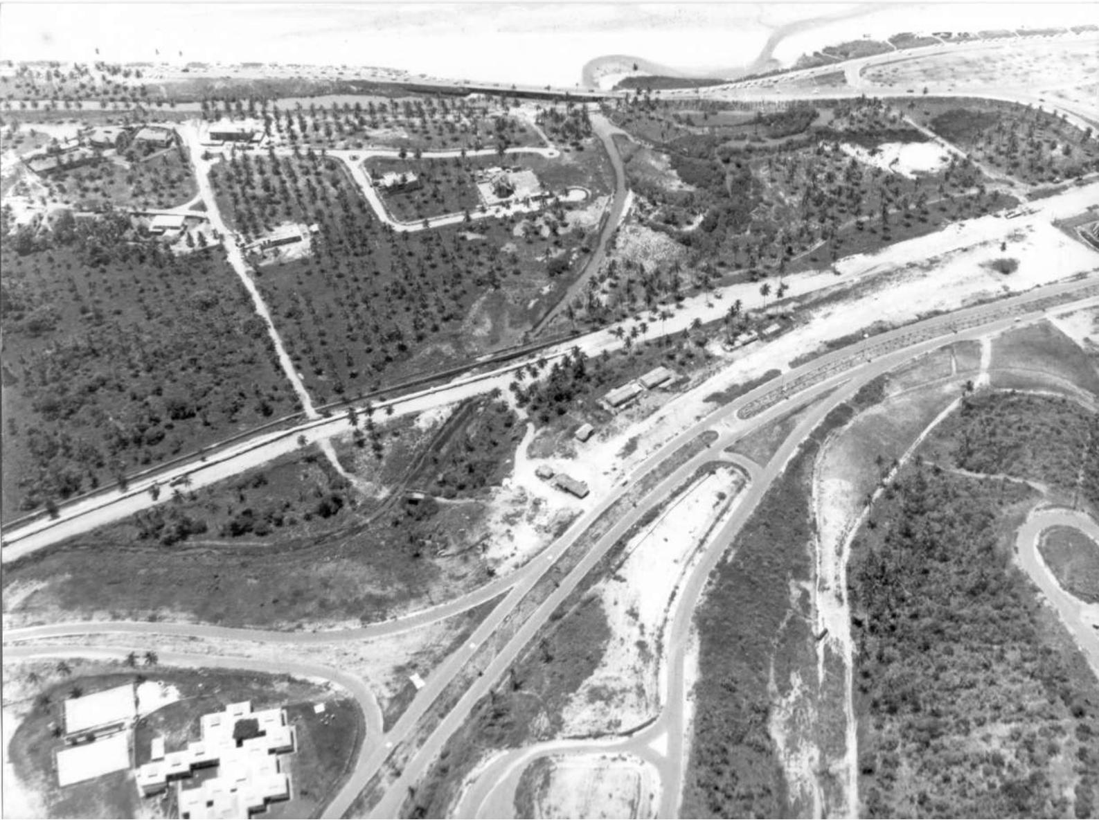
Estrada da Embasa - Patamares
