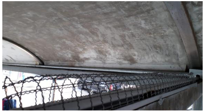
Figura 8: Grade de proteção das luminárias devidamente soldadas
