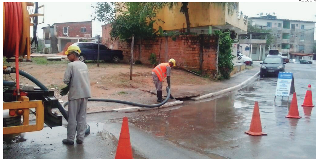
Entre as ações, funcionários municipais fazem trabalho de drenagem no Jardim Nova Esperança
