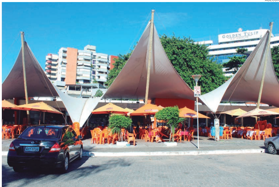
Os boxes do antigo Mercado serão demolidos para dar continuidade ao novo projeto de urbanização da área
