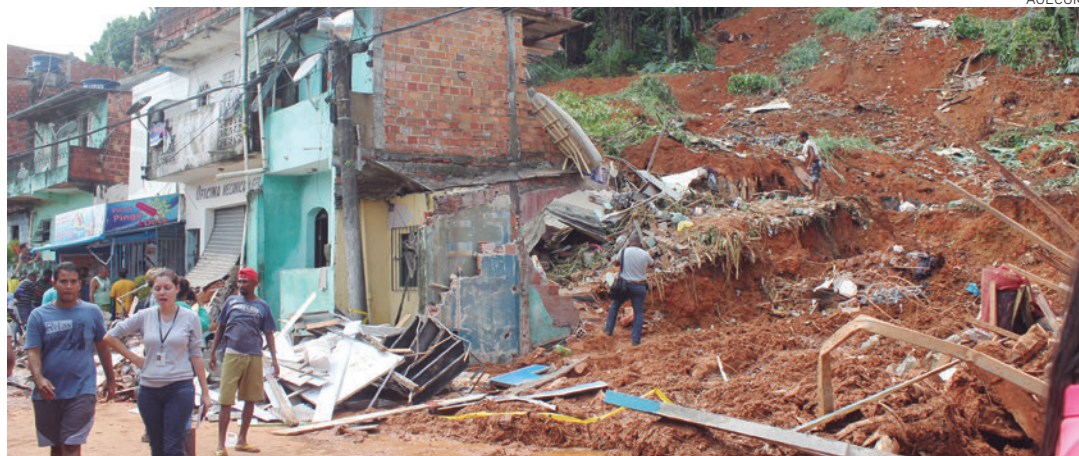
Dos 10 imóveis demolidos pela Prefeitura, três foram na Baixa do Fiscal onde houve deslizamento de encosta
