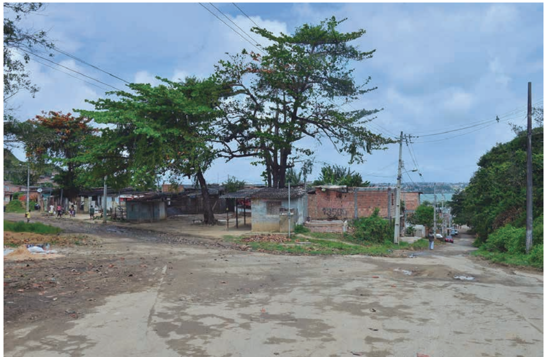
O prefeito assinará ordem de serviço para drenagem e pavimentação da Rua Eduardo Dotto
