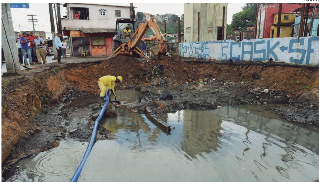
Na Baixa do Fiscal, onde a via está sendo duplicada, as obras avançam no sistema de drenagem
