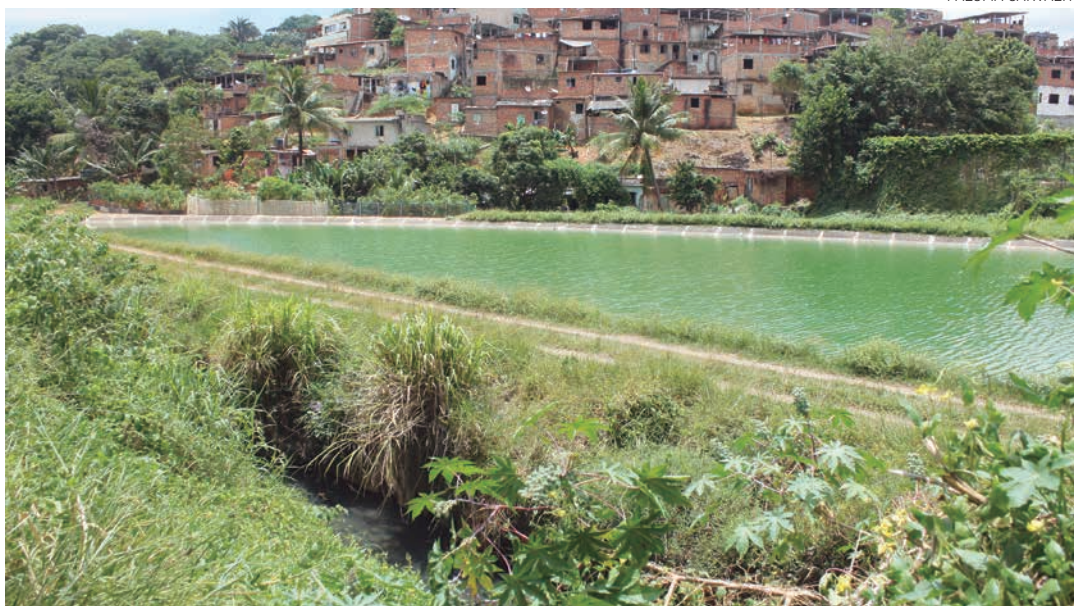
A obra vai durar nove meses e será feita numa área de vale ainda sem ocupação, medindo 1,2 mil metros
